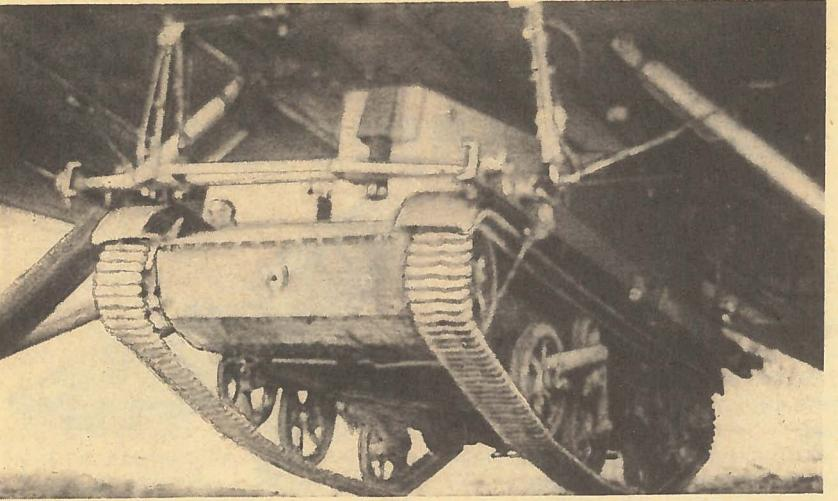
Эксперименты... Таким образом под «брюхом» четырехмоторного бомбардировщика ТБ-3 подвешивали бронеавтомобили и легкие танки.
