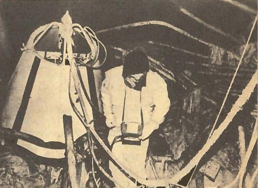
В реакторный зал разрушенного блока удалось проникнуть человеку. И не просто проникнуть, а взобраться на самое опасное место — на «Елену». Так называют здесь металлоконструкцию крышки реактора — схемы «Е», которая при взрыве стала почти вертикально, вырвав при этом из аппарата сотни технологических трубок.
