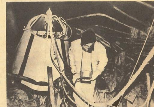
*В реакторный зал разрушенного блока удалось проникнуть человеку. И не просто проникнуть, а взобраться на самое опасное место — на «Елену». Так называют здесь металлоконструкцию крыши реактора — схемы «Е», которая при взрыве встала почти вертикально, вырвав при этом из аппарата сотни технологических трубок.*
