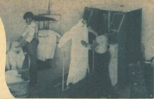
универсальная машина для влажно-тепловой обработки в связи с автоматической системой складывания
