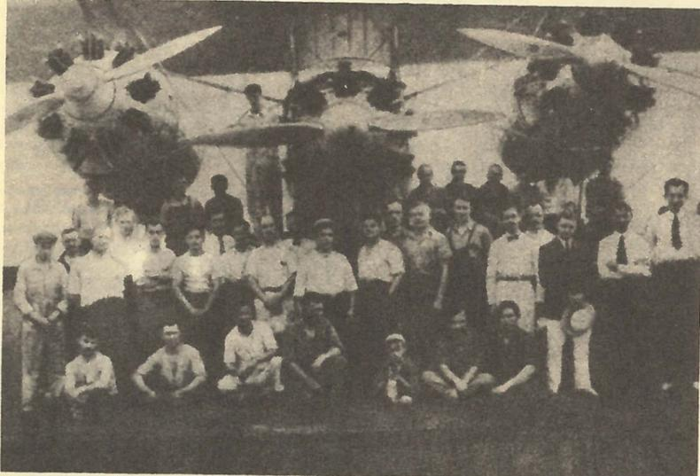
строения одного из двигателей. По сходным причинам в конструкцию, дабы уменьшить шанс на неудачу, были введены относительно узкая хорда и большой размах крыла, очень длинный фюзеляж и тандемное расположение двигателей близко к осевой линии. «Гранд» весил около 9 тыс. фунтов. Размах крыльев составлял 92 фута, самолет был оснащен четырьмя 4-цилиндровыми двигателями «Аргус» с водяным охлаждением, каждый мощностью в 100 л. с.
