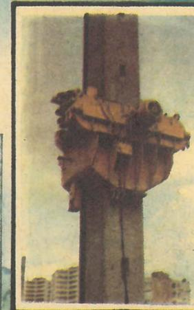
Такой подъемник с индивидуальным электроприводом устанавливается в обхват колонны.
