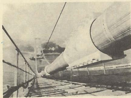
пеше завершилось строительство одного из самых замечательных сооружений в Европе — висячего моста (4). Четыре его несущие части поддерживали трехпролетное мостовое полотно шириной 14 м. В середине — уникальный по тем временам пролет длиной 203 м. К нему примыкают два боковых, по 93 м каждый.
