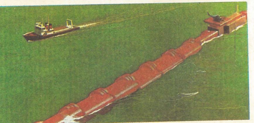
Волновая электростанция, разработанная инженером из Эдинбурга С. СОЛТЕРОМ, представляет собой цепочку толстых крыльев, вращающихся под воздействием волнения на эксцентрических валах.
