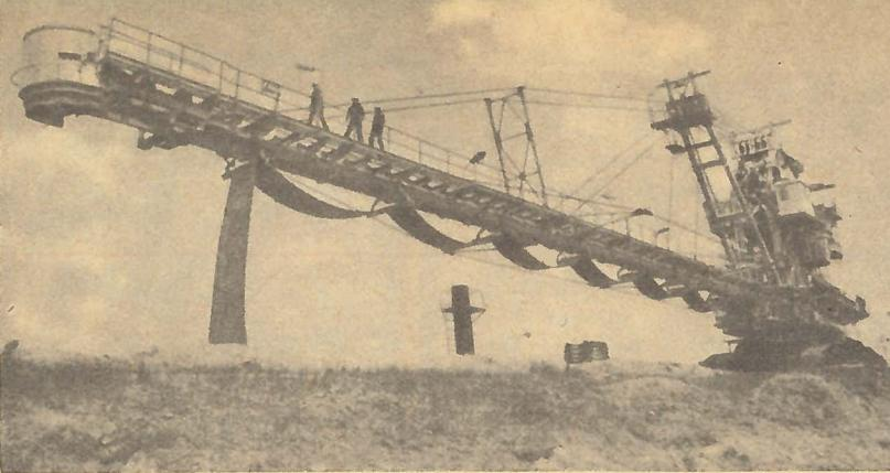
В Экибастузе закончен монтаж мощного ленточного перегружателя П-1600 на гусеничном ходу. Машина весом около 500 т изготовлена на Донецком машиностроительном заводе имени Ленинского комсомола и собрана на месте специалистами монтажно-наладочного управления Экибастузуглеавтоматика. Гигант способен за час подавать по 1600 м<sup>3</sup> породы на высоту 21 и расстояние до 50 м. Перегружатель будет использоваться на крупнейшем в стране угольном разрезе «Богатырь» в паре с мощным экскаватором.
