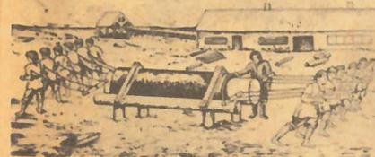
Обработка цилиндра для паровой машины Ньюкомена английским мастером Р. РЕЙНОЛЬДСОМ в 1760 г. Одна шестерка рабочих тянет колоду с резаками, другая отдыхает.
