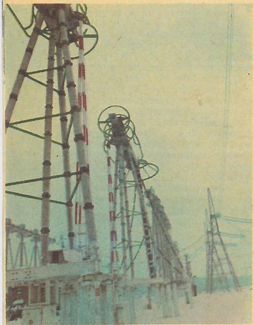
Мощные выключатели тока, разымающие цепь при нормальных и аварийных ситуациях, рассчитаны на напряжение 1150 кВ.
