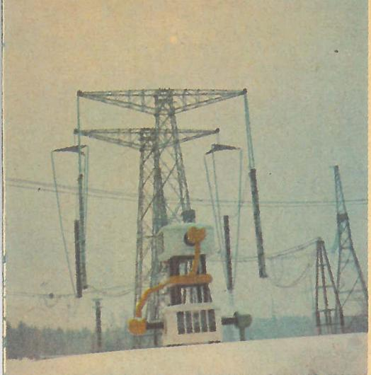
Шинный мост для подачи напряжения на высоковольтную аппаратуру подстанции ЛЭП-750 (вверху).
