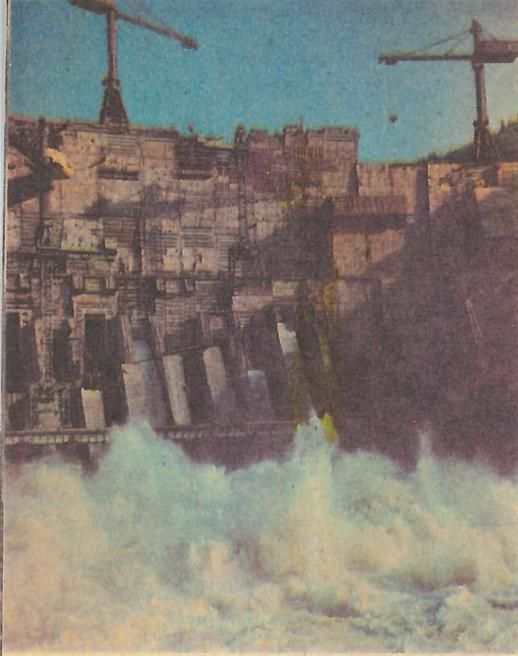
Энергия холостых сбросов в нижний бьеф достигает мощности 25 млн. кВт. Она гасится в специальном «водобоном колодце» длиной 144 м и глубиной 46 м.
