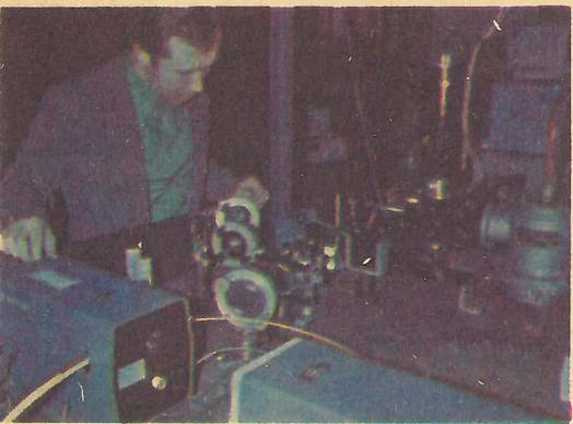
В. И. Балыкин в лаборатории лазерной спектроскопии ИСАН проходит эксперимент по лазерному охлаждению атомов.
