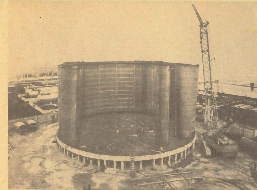
Раскручивание рулонов изотермического резервуара для жидкого аммиака (емк. 10 тыс. т).
