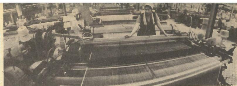
На заводе «Сиболокно», первая очередь которого была введена в канун XXVI съезда КПСС, начато изготовление волокна из натуральной целлюлозы. Прочность его в полтора раза выше, чем у обычного вискозного волокна, а усадка не превышает 5%. Ткань из сиблона гигроскопична, не электризуется, и изделия из него сохраняют форму после стирки.
