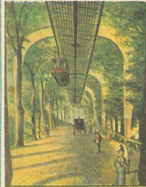
подвесная монорельсовая дорога в Вуппертале вступила в строй. Сначала ее длина составляла 4,5 километра, а двумя годами позже увеличилась до 13,3 км. Вагонный парк состоял из 30 вагонов, каждый на 130 пассажиров. Для строительства было использовано 19 200 тонн стали для рельсовых путей и 472 опоры...
