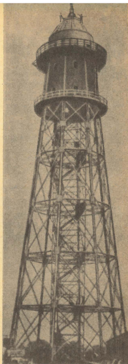
Общий вид стационарной причальной мачты в Кардингтоне, вокруг которой гигантские «сигары» крутились как флюгера.
