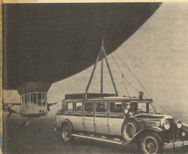
Слева: новинка полувеновой давности — мобильная мачта, установленная на автомашине.
