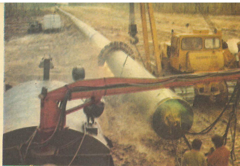
Комплекс «Север-1». Фото В. Дудко
