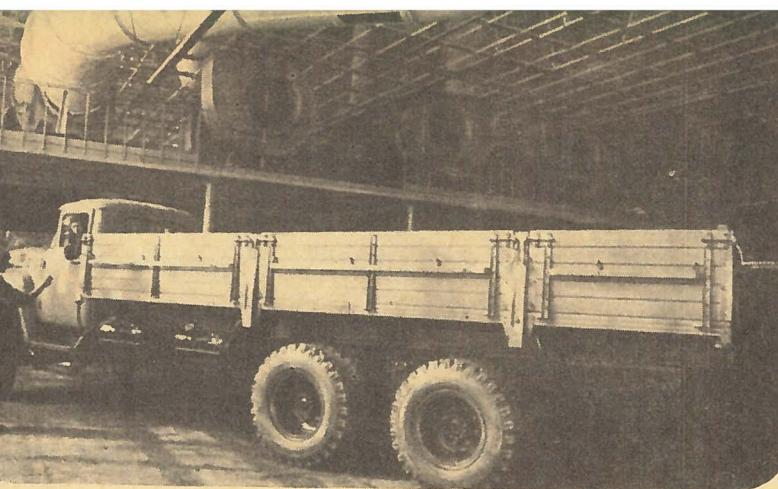
Новые трехосные 8-тонные грузовые автомобили ЗИЛ-133Г1 (см. снимок) начали выпускать завод имени Лихачева для сельского хозяйства. Эта длиннобазовая машина с большим объемом кузова предназначена для работы без прицепа на дорогах с твердым покрытием. Мощность двигателя 130 л. с., скорость автомобиля до 80 км/ч, наименьший радиус поворота 11,6 м. Колесная формула 6×4 — колеса всего 6, из них 4 задних — ведущие. Кабина трехместная.
