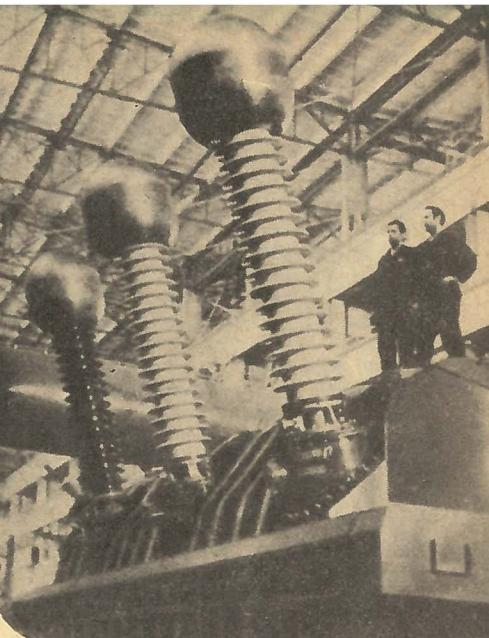
**Д**осрочно изготовлен трансформатор мощностью в 1 млн. кВт (см. фото) — в полтора раза больше, чем мощность Днепрогэса. Новый трансформатор, предназначенный для Углегорской ГРЭС, позволит ежегодно экономить свыше 100 тысяч рублей.
