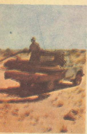
другой пластик фирмы — хостален — незаменим при оросительных работах. Трубы из него легко транспортируются, легко укладываются в грунт и не подвергаются разрушительному действию солнца и непогоды (ФРГ).
