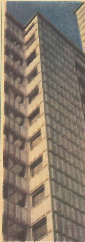
расширении рынка их сбыта. Фотографии свидетельствуют о некоторых новых возможностях применения пластмасс. На верхнем снимке — строительный пластик хостаит. Плиты и панели из этого материала не требуют сложной очистки и периодической окраски, поскольку пластик устойчив
