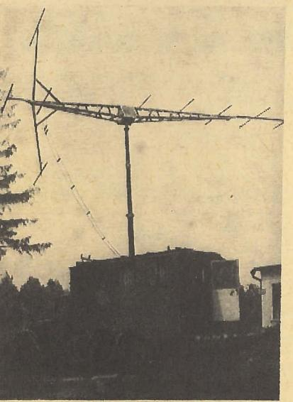
В 1939 году были созданы зенитные радионавигаторы, использующие эффект Доплера, — Б-2 (вверху) и Б-3. (На снимке внизу слева показан один из двух комплектов Б-3 — установка для определения угла места цели.)
