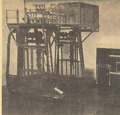
**Н**а вагоноремонтном заводе имени С. М. Кирова изготовлена универсальная самоходная установка с камерой для автоматической окраски и сушки цельнометаллических пассажирских вагонов. Краска на крыши вагонов подается через два распылителя, а на стены — через шесть (по три с каждой стороны). Производительность установки — шесть вагонов за смену. Сушатся вагоны в камере теплом от электрических обогревателей.
