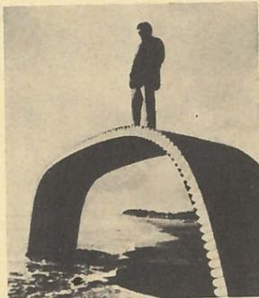
**СОТОВЫЕ СТРОИТЕЛЬНЫЕ ОБОЛОЧКИ.** Оболочки, состоящие из коротких отрезков тонкостенных алюминиевых труб, зажатых между алюминиевыми листами, оказались весьма перспективным конструкционным материалом при сооружении перекрытий для спортивных и зрительных залов, складов и производственных помещений, в которых нежелательна установка внутренних опор. Оболочке может придаваться практически любая форма — полукруглая, овальная, близкая к прямоугольной (США).
