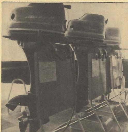
фикация этой марки мотора, «Нептун-2». Обладая такими же преимуществами, как и «Нептун-М», новинка существенно отличается от всех типов лодочных подвесных моторов тем, что вместо винта на ней установлен водометный движитель, который более надежен в работе. С винтом не помчишься, скажем, через заросли осоки, а с водометом можно. Менее опасными становятся плавающие предметы, мелководье.
