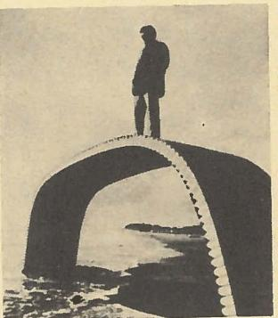
**СОТОВЫЕ СТРОИТЕЛЬНЫЕ ОБОЛОЧКИ.** Оболочки, состоящие из коротких отрезков тонкостенных алюминиевых труб, зажатых между алюминиевыми листами, оказались весьма перспективным конструкционным материалом при сооружении перекрытий для спортивных и зданий, в которых нежелательна установка внутренних опор. Оболочка может придаваться практически любой форме — полукруглая, овальная, близкая к прямоугольной (США).
