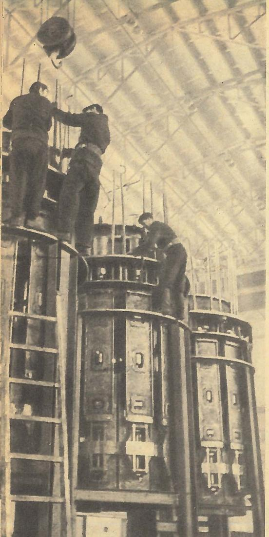
На заводе электротермического оборудования изготавливается крупнейшая в стране руднотермическая электропечь модели РКЭ-72Ф, предназначенная для получения минеральных удобрений. Агрегат высотой в 12-этажный дом будет установлен на Чимкентском фосфорном заводе. На снимке — сборка узлов электропечи.
