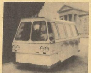
Машина весит около 1500 кг (из них 500 кг — аккумуляторная батарея). Так как проектная скорость автобуса не превышает 10—15 км/ч, он может быть использован в качестве внутривозовского транспорта, для обслуживания торговых центров, лагерей и т. п. Электроавтобус рассчитан на непрерывную работу в течение 8 часов при 500 и более остановках и запусках. (США).
