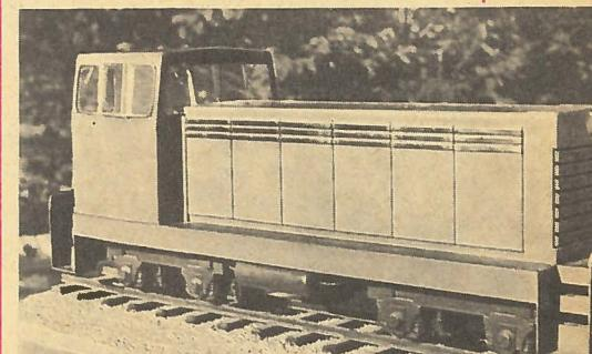
**TU-7 — НОВЫЙ УЗКОКОЛЕЙНЫЙ ТЕПЛОВОЗ**, созданный на Камбарском машиностроительном заводе. По сравнению с предыдущими моделями на нем улучшены условия работы машиниста и еще более автоматизировано управление. Вес локомотива снижен примерно на 20%.
