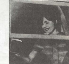
**МАГНИТНЫЕ ПРОТИРКИ.** Одна из фирм приступила к изготовлению приспособлений для одновременной двусторонней протирки оконных стекол. Для этого применяются две губки — одна с наружной стороны, другая с внутренней, — которые прижимаются к стеклу сильными магнитами. Достаточно передвинуть губку на одной стороне стекла, чтобы одновременно передвинулась и вторая (США).
