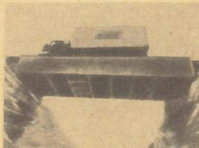
По расчетам, мост может выдержать до шести грузовиков весом по 5,5 т. Он построен одной производящей бумагу фирмой — в доказательство, что этот материал зря считают непрочным (США).
