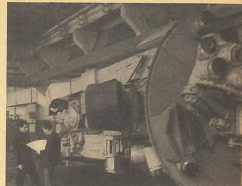
● Прошел испытание трехкоординатный вертикально-фрезерный станок повышенной точности. Детали самой сложной конфигурации обрабатываются на нем по заранее заготовленной программе, записанной на перфоленте.
