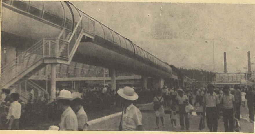
Движущийся тротуар, заключенный в пластмассовую трубу.
