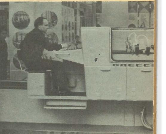
**ВЫСOKIE TOЧNOSTЬ, SKOРОСТЬ И ПРОИЗВОДИТЕЛЬНОСТЬ** позволили «Одессе-70» намного опередить все другие фотокопировальные машины. Со скоростью до 6 м в минуту машина режет пламенем листовой прокат толщиной от 5 до 100 мм. Из-под горелок выходят заготовки под сварку любой криволинейной формы — они настолько точно обрезаны, что подгонять их на месте не приходится.
