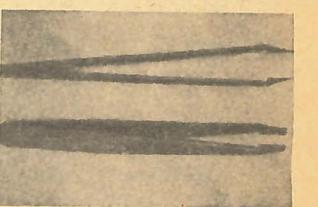
**ПЛАСТИМАССОВЫЙ ИНСТРУМЕНТ.** Пинцеты из пластичной массы, армированные стекловолокном, применяемые при сборке точайших деталей полупроводниковых приборов и устройств из кремния, герmania и арсенида галлия, начала выпускать одна фирма в городе Лос-Анджелесе (США).
