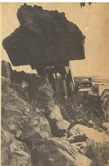
**В НАУЧНО-ИССЛЕДОВАТЕЛЬСКОМ И ПРОЕКТНОМ ИНСТИТУТЕ** горного машиностроения спроектирован и изготовлен промышленный образец ковшовой погрузо-доставочной машины. Она грузит и перевозит горные породы при расчистке карьеров, выполняет различные вспомогательные работы в шахтах. Мощность двигателя — 240 л. с., грузоподъемность — 10 т, емкость ковша — 50 куб. м.
