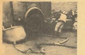
**БАЛЛОНЫ-СПАСАТЕЛИ.** Пожарные города Бедфоршира получили большие надувные баллоны из прочной армированной пластиком резины. С помощью этих баллонов приподнимают потерпевшие аварию автомобили, чтобы как можно быстрее извлечь из-под них пассажиров. Надувные опоры удерживают даже стены, которые вот-вот могут обрушиться (Англия).
