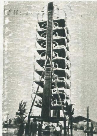
**ГАРАЖ-ОБОИМА.** 21 автомобиль умещается в вертикальном полуоткрытом гараже-стоянке размерами 7x8 м. Владелец может получить свою машину, опустив в автомат плату за стоянку (США).
