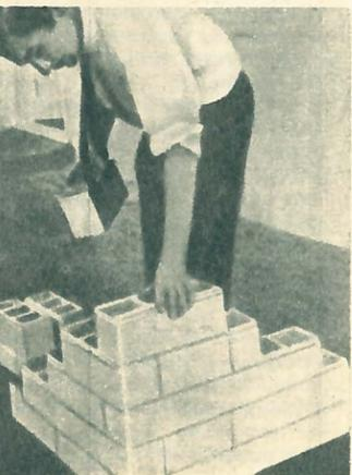
производству кирпича из пластических масс. Например, фирма «Инка» в 1968 году выпустила около 40 млн. штук такого кирпича, предназначенного главным образом для строительства в сельских местностях и для возведения внутренних стен (Англия).
