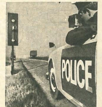
**НЕ ВЫХОДЯ ИЗ МАШИНЫ!** Чтобы включать на автострадах фонари, которые зажигаются только при густом тумане, дорожные полицейские используют лучевые пистолеты. Для этого им даже не нужно выходить из автомашины (Англия).
