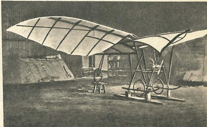
Аппарат БИЧ-18, построенный Б. Чебановским в 1934 году. У него четыре крыла-«конончицы». Аппарат испытывался как планер, машущие крылья удлиняли полет.
