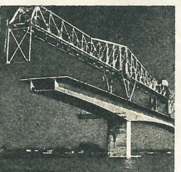
**ШАГАЮЩИЙ МОСТ.** На снимке показано устройство, значительно упрощающее строительство мостов любой конструкции и размеров. Это одновременно и передвижной кран и «леса». Перемещаясь по уже построенной части моста, машина достигает очередного пролета. Когда будет готов и он — следующий шаг. Устройство испытано при возведении почти трехкилометрового моста над одним из морских проливов (Франция).
