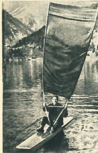
**ПОРТАТИВНЫЙ ПАРУС.** Этот оригинальный «парусник» создан любителем. Водитель, сидя на широкой (60 см) пластмассовой доске или в гоночной лодке, держит рамку с парусом обеими руками. Для маневрирования рамку нужно соответствующим образом поворачивать относительно ветра. Для торможения служит кормовое весло (ФРГ).
