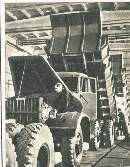
**ЭТИ ГРУЗОВЫЕ МАШИНЫ С КУЗОВАМИ** ковшового типа собираются на Кременчугском автозаводе. При полной нагрузке (12 т) скорость их 68 км/час. На этом же заводе собирают седельные тягачи такой же грузоподъемностью и скоростью и автомобили общего назначения для перевозки грузов весом до 11 т. Их скорость — 65 км/час. Все автомобили вооружены четырехтактными восьмицилиндровыми двигателями ЯМЗ мощностью 215 л. с.
