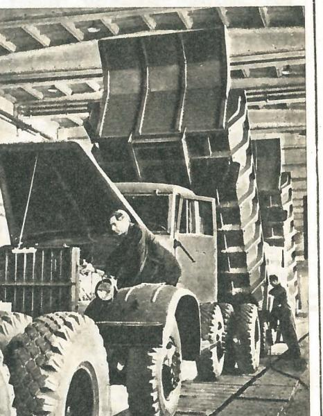
**ЭТИ ГРУЗОВЫЕ МАШИНЫ С КУЗОВАМИ КОВШОВОГО ТИПА** собираются на Кременчугском автозаводе. При полной нагрузке (12 т) скорость их 68 км/час. На этом же заводе собирают седельные тягачи такой же грузоподъемностью и скоростью и автомобили общего назначения для перевозки грузов весом до 11 т. Их скорость — 65 км/час. Все автомобили вооружены четырехтактными восьмицилинровыми двигателями ЯМЗ мощностью 215 л. с.
