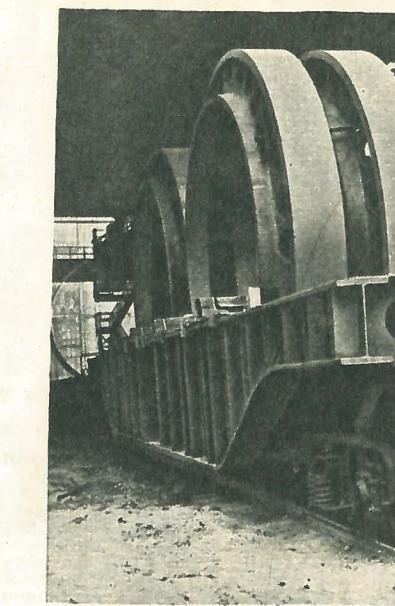
установленным на самом автоприцепе. Теперь взгляните на фото 4. Эта башня доставлена со Ждановского завода (СССР) на строящийся в Кремниковицах (Болгария) металлургический комбинат. Вес башни 93 т, длина 40 м. Роль тяжелой платформы автоприцепа здесь играет сам груз.
