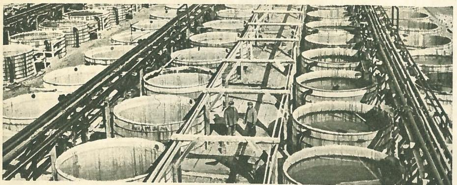
Воды, в которых содержится йод, обычно связаны с нефтяными месторождениями. Извлекаются они на поверхность вместе с нефтью. В специальных отстойниках вода отделяется от нефти и затем по каналам или трубопроводам поступает в адсорбционные хранилища юдистых заводов. На снимке — отделение адсорбции Бакинского йодового завода.
