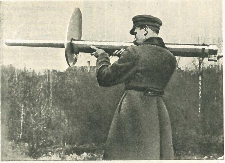
1931 год. Испытания противотанкового реактивного ружья, которое впоследствии американцы стали именовать по-своему — «базукой».
