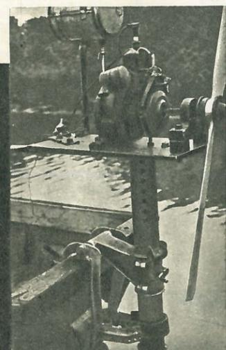
«У нас много озер, — пишет читатель К. ХОДЫРЕВ, — но все они мелководные. На весла, на винт подвешенного мотора наматываются водоросли. Вот я и сделал воздушный винт. По самым мелким местам, через водоросли, навстречу сильному ветру толкает лодку винт. Мотор «Дружба» позволяет развивать скорость в 12 км/час. В лодке — четыре пассажира».
