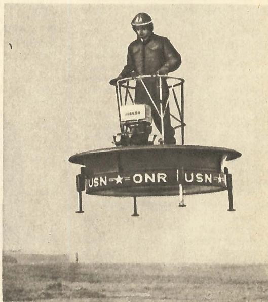
Нерешенной пока остается проблема аварийного спуска. Ведь в случае отказа одного из моторов аппарат упадет на землю, как камень. Если проблема аварийного спуска будет решена окончательно, то полеты на «сковородке» из дому на службу и обратно станут столь же возможными, как посадки на мотоцикле.
