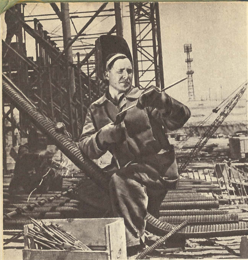
Бригадир электросварщиков Г. Шокин.
