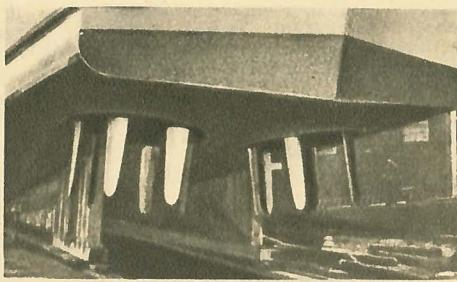
Судно с «циклоидальным» движителем.
