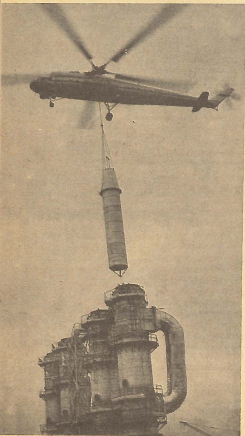
«Летающий» кран незаменим при реконструкции действующих цехов, когда традиционная грузоподъемная техника оказывается бессильной. Установку сирубберов и газоходов на Синарском трубном заводе выполняют специалисты треста «Востокметаллургмонтаж».
